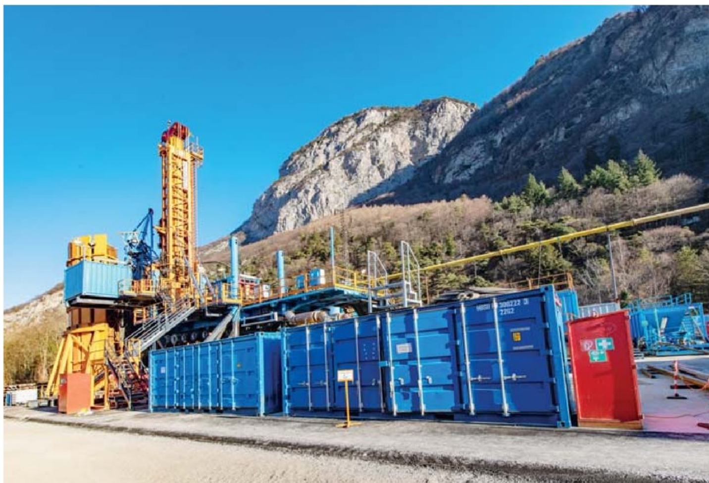
L'activité de forage débutera la semaine prochaine et devrait durer entre cinq et six mois. SACHA BITTEL
