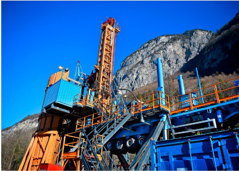
L'impressionnante tour de forage percera le sous-sol jusqu'à 2500 mètres au moins. CHANTAL DERVEY
